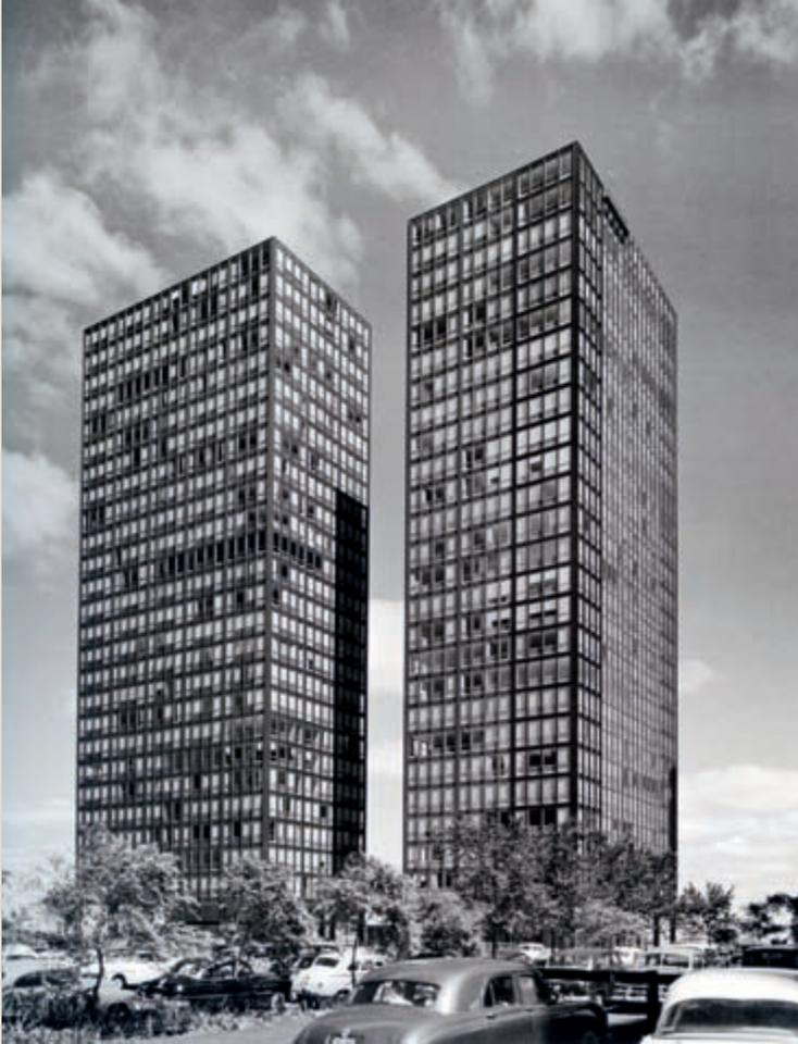
Die Konstruktion aus Stahl bleibt auch bei den fertigen Häusern von außen sichtbar.
