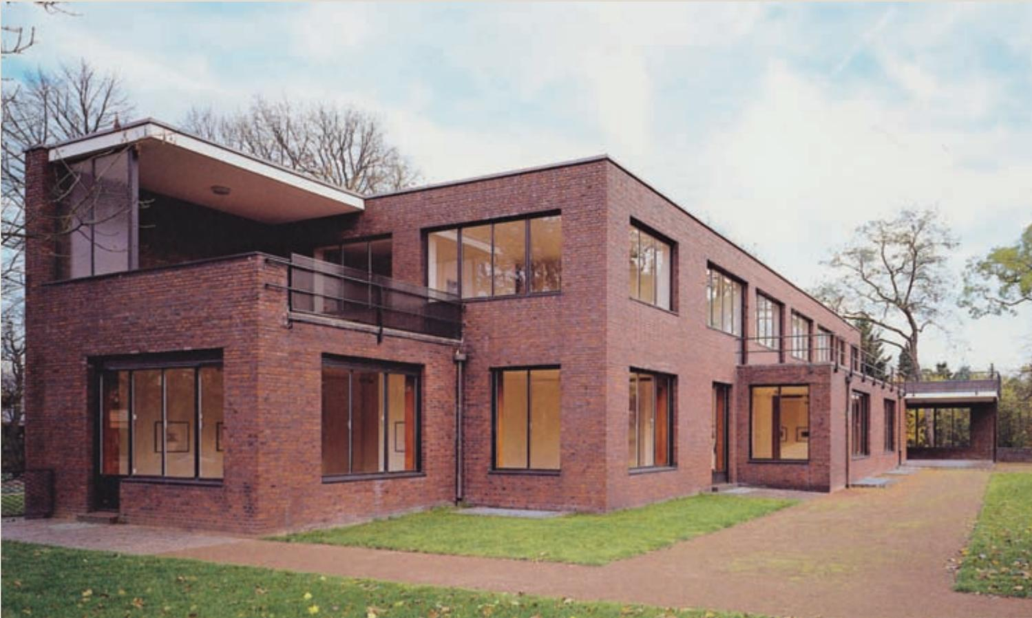
Die Ziegelmauern vom Haus Esters sind sogenannte Vorhangfassaden, weil sie wie Vorhänge am Stahlskelett aufgehängt werden. Das dahinter liegende Stahlskelett trägt alle Decken und Wände.
